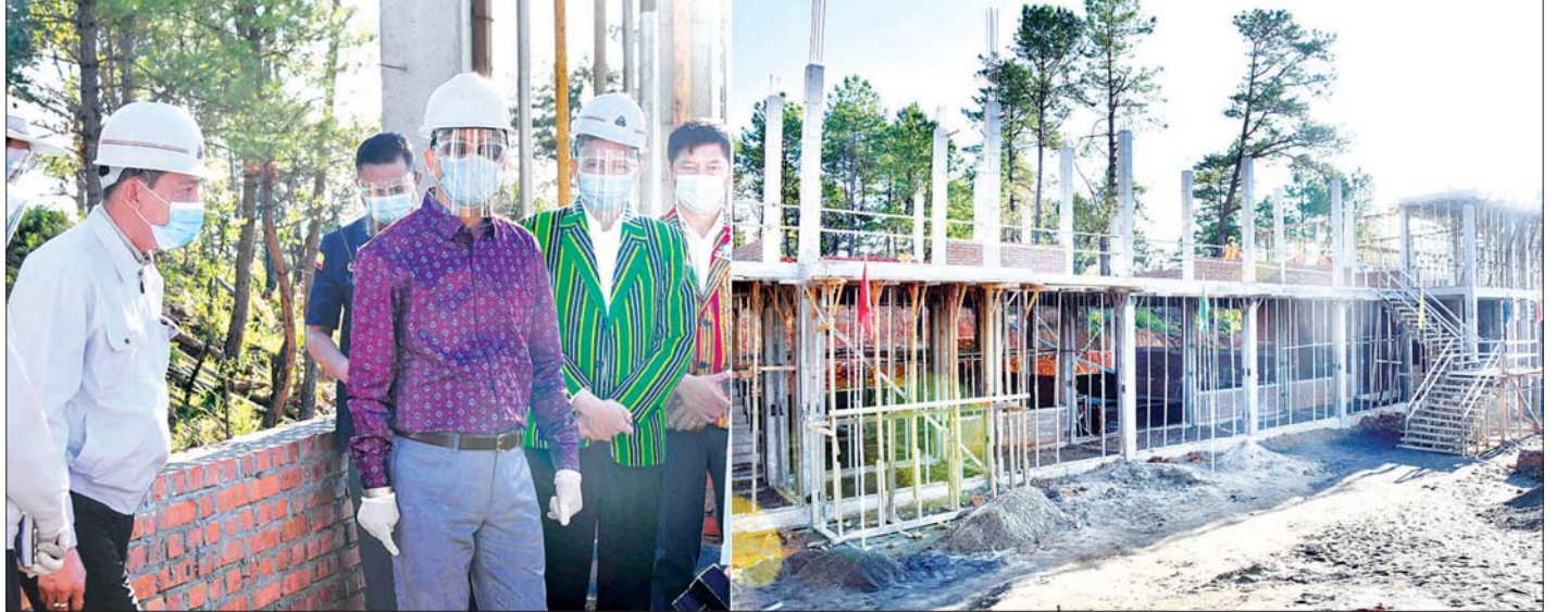
ဒုတိယသမ္မတ ဦးဟင်နရီဗန်ထီးယူ မင်းတပ်ကောလိပ် စာသင်ဆောင် ဆောက်လုပ်နေမှုကို ကြည့်ရှုစစ်ဆေးစဉ်။
