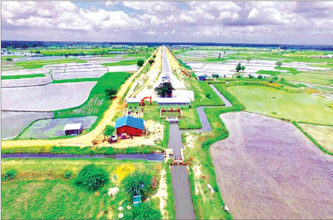
ရေတင်အဆင့်(၂) ရေစုကန်၊ ရေတင်စက်ရုံ၊ ဓာတ်အားခွဲရုံနှင့် ရေငြိမ်ကန် မြင်တွေ့ရစဉ်။
