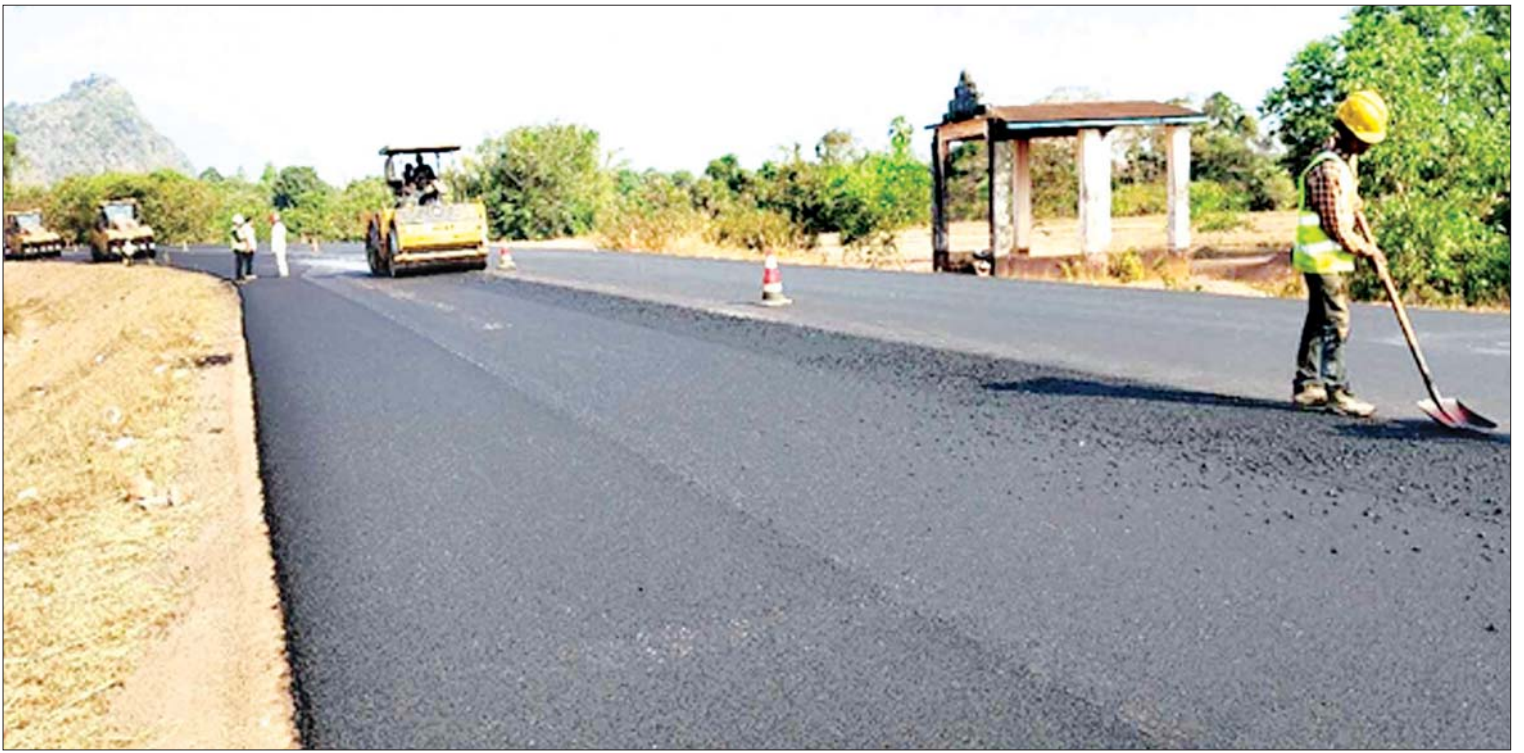
၅-၁၁-၂၀၁၉ ရက်တွင် အိန္ဒူ - ကော့ကရိတ်လမ်းအပိုင်း ကတ္တရာကွန်ကရစ်အပွန်းခံလွှာ ခင်းနေမှုကို တွေ့ရစဉ်။
