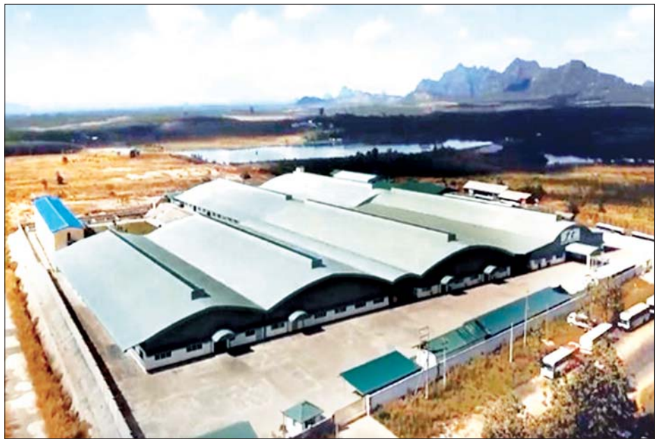
ဆွယ်တာနှင့်အဝတ်အထည်များ ထုတ်လုပ်သည့် Fulltex Co.,Ltd အဆောက်အအုံကို တွေ့ရစဉ်။
