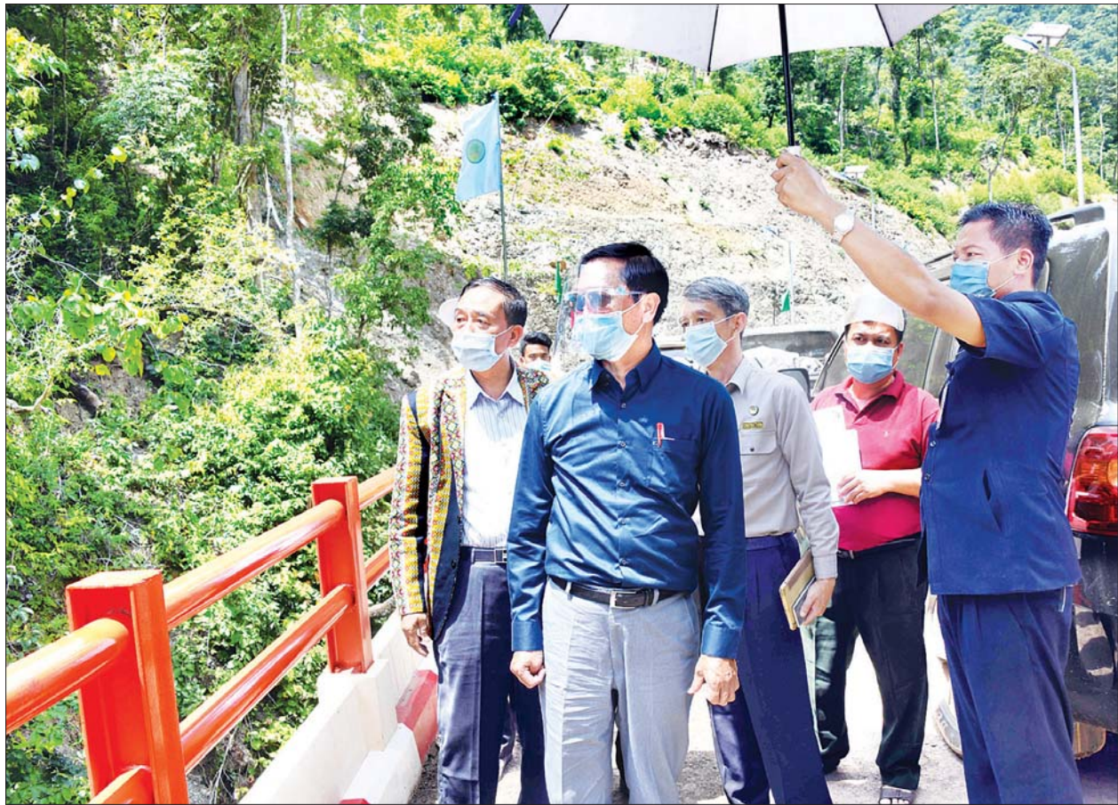
ဒုတိယသမ္မတ ဦးဟင်နရီဗန်ထီးယူ မှန်တော - ဟာသာ - ဟားခါးလမ်းပေါ်ရှိ ဒေါင်ဗား ချောင်းကူးတံတား တည်ဆောက်ပြီးစီးနေမှုကို ကြည့်ရှုစစ်ဆေးစဉ်။
