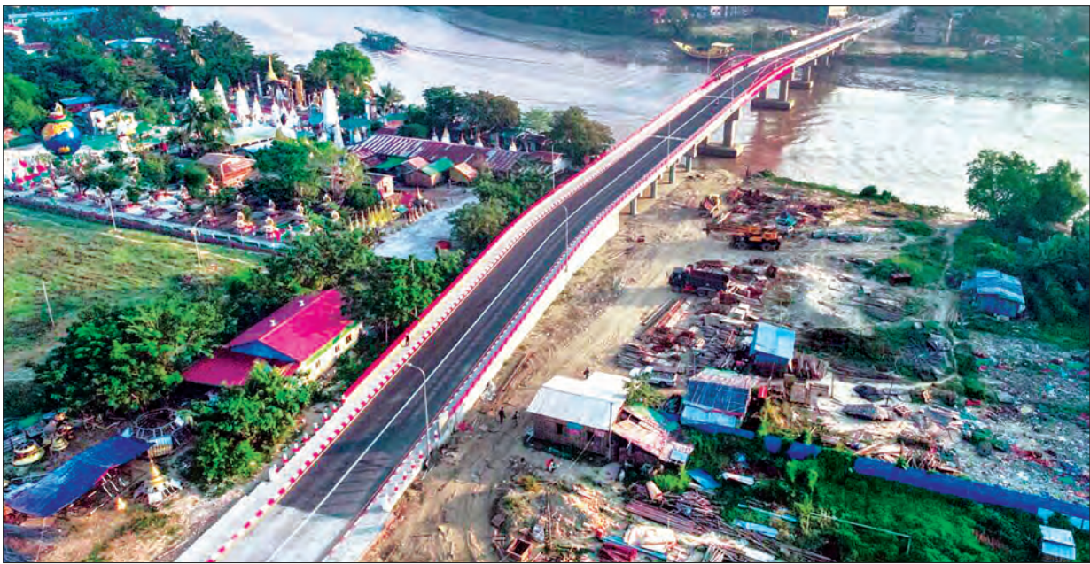
သယံဇာတကျွန်းမြို့နယ်နှင့် ဒဂုံမြို့သစ်တောင်ပိုင်းမြို့နယ်တို့ကို ဆက်သွယ်ထားသော ငမိုးရိပ်တံတားသစ် ကမာကြည်-၂ ကို တွေ့ရစဉ်။
