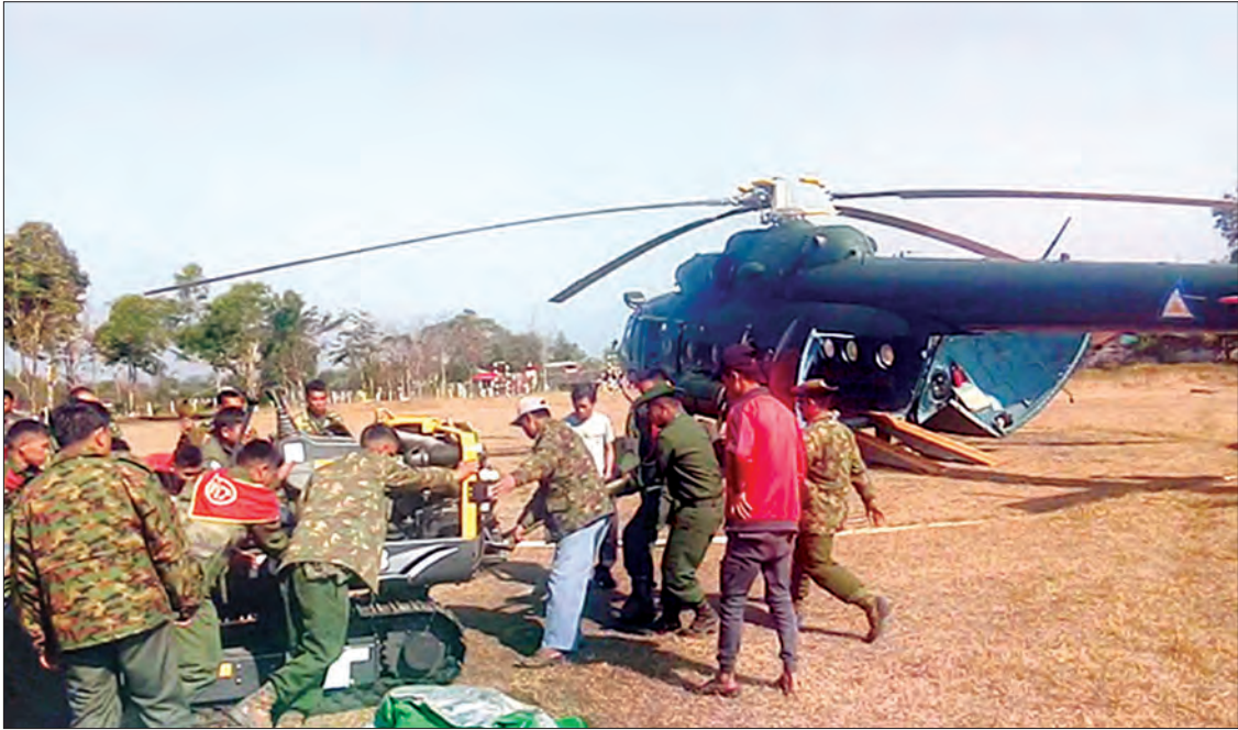
မဂ္ဂဇ-ခေါင်လန်ဖူးလမ်းကို ခေါင်လန်ဖူးဘက်ခြမ်းမှ ဖောက်လုပ်ရန်အတွက် စက်ယန္တရားများ ရောက်ရှိစဉ်။
