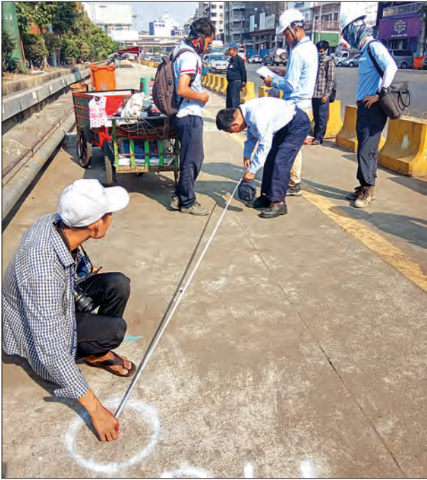
ဒလမြစ်ကူးကြိုးတံတား၏ ရန်ကုန်ဘက်ခြမ်း ချဉ်းကပ်တံတား ပိုင်တိုင်များအတွက် နေရာတိုင်းတာ အမှတ်အသားများ ပြုလုပ်နေသည့်ကို တွေ့ရစဉ်။
