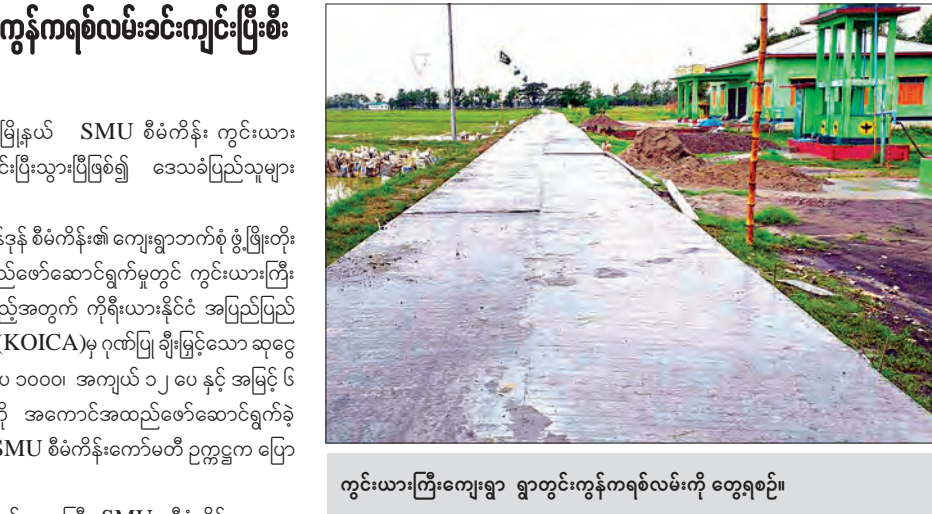
ကွင်းယားကြီးကျေးရွာ ရွာတွင်းကွန်ကရစ်လမ်းကို တွေ့ရစဉ်။ ဈေးကွက်သို့ အချိန်တိုအတွင်း ပို့ဆောင်နိုင်ပြီဖြစ်ကြောင်း ဒေသခံတစ်ဦးက ပြောသည်။ နန်းထိုက် (KGD)
