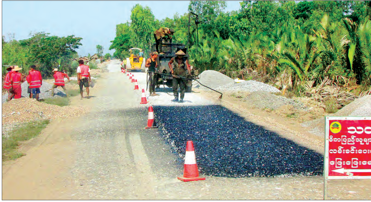
ကျုံကဒွန်း-စက်ဆန်းလမ်းပိုင်း၌ ကတ္တရာခင်း ဆောင်ရွက်နေစဉ်။
