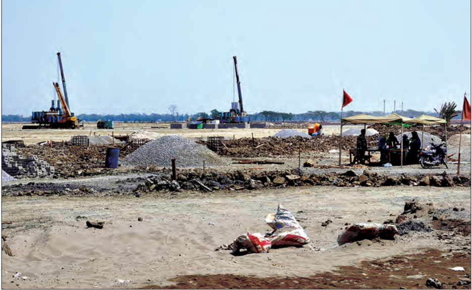
ငါးမွေးမြူထုတ်လုပ်မှု အထူးဇုန်တွင် ခေတ်မီငါးသားဖောက်စက်ရုံတည်ဆောက်ရေးလုပ်ငန်းများ ဆောင်ရွက်နေစဉ်။
