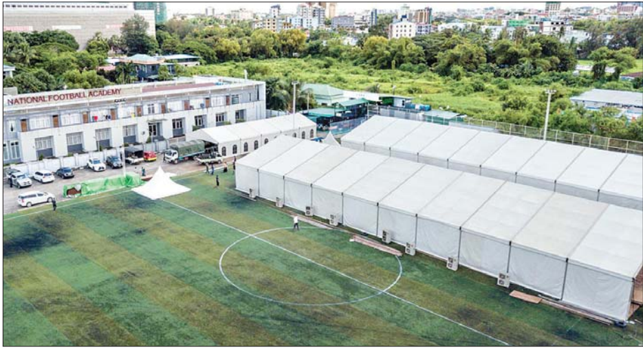
ကိုဗစ်-၁၉ ရောဂါ ကုသရေးဌာန (သုဝဏ္ဏ) တည်ဆောက်နေမှုကို တွေ့ရစဉ်။ ဓာတ်ပုံ - ရောဂါတီဖောင်ဒေးရှင်း
