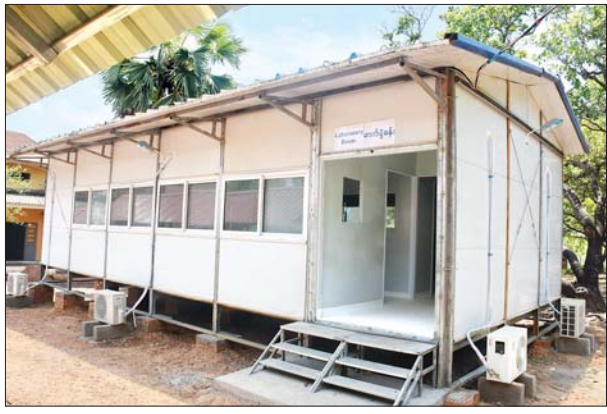
ဗဟိုဝန်ထမ်းတက္ကသိုလ် (အောက်မြန်မာပြည်) ကိုဗစ်-၁၉ ရောဂါ ကုသရေးဌာနရှိ ဓာတ်ခွဲခန်းအဆောက်အအုံကို တွေ့ရစဉ်။
