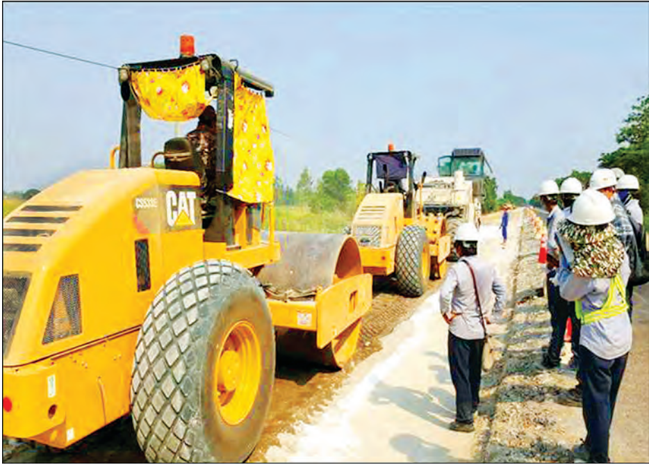
ဧရာဝတီတိုင်းဒေသကြီး မအူပင်-ကျိုက်လတ်-ဈာပုံလမ်း အဆင့်မြှင့်တင်ဆောင်ရွက်နေမှုကို တွေ့ရစဉ်။
