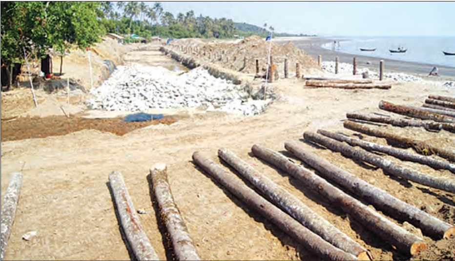
ဟိုင်းကြီးကျွန်းမြို့ အမှတ်(၃)ရပ်ကွက် ကပ္ပလီကမ်းခြေရှိ ပင်လယ်ရေတိုက်စားခံရသောနေရာ၌ ယခုတည်ဆောက်နေသည့် အရှည်ပေ ၉၇၀ ရှိ ရေတားကျောက်စီတမံ လုပ်ငန်းခွင်ကိုတွေ့ရစဉ်။
